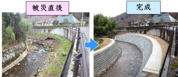
▲令和3年12月に完成した生居川（上山市大字下生居川）の河川災害復旧工事
